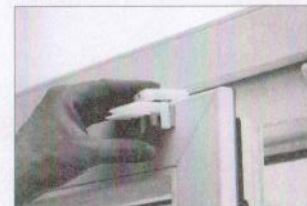
Die Klemmträger bei gekipptem Fenster auf den Flügel in die gewünschte Position setzen.
