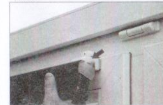
Oberschiene in die entsprechende Schlitz- Öffnung des Kunststoffträgers führen und einklicken.
