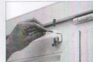
Bei geschlossenem Fenster mit dem beiliegendem Imbusschlüssel den Träger fest anziehen.
